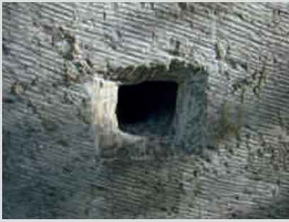
Fig. 2.- Sur une face non apparente, encoche de fixation d'un élément métallique déposé ; on notera le soin apporté aux tailles, ainsi que le soin du démontage, toute trace du goujon et de son probable scellement au plomb a disparu. © Francis Tourneur, 2019.
