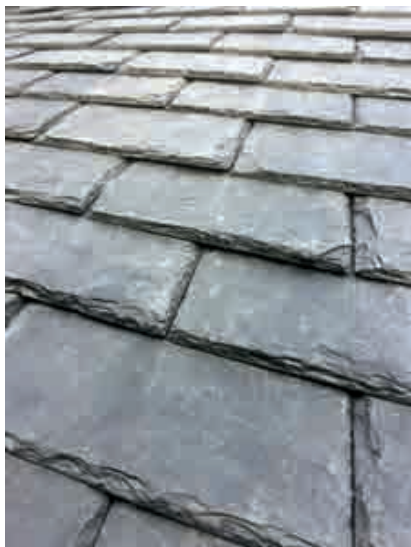
Fig. 19.- Détail d'épaufure (contours biais des ardoises).
