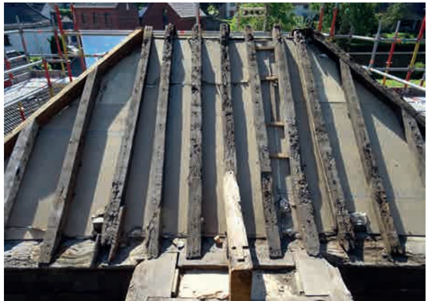
Fig. 16.- Chevronnage de la toiture haute avant restauration.
