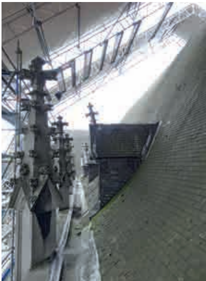
Fig. 8.- Installation de chantier : couverture provisoire. © Architectes associés s.a., société civile d'architectes.
