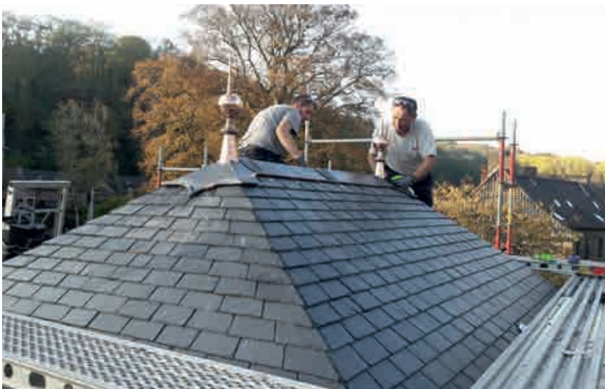
Fig. 27.- Pose des épis de faitage (en cuivre), sur le volume principal. © Gérard Bavay.
