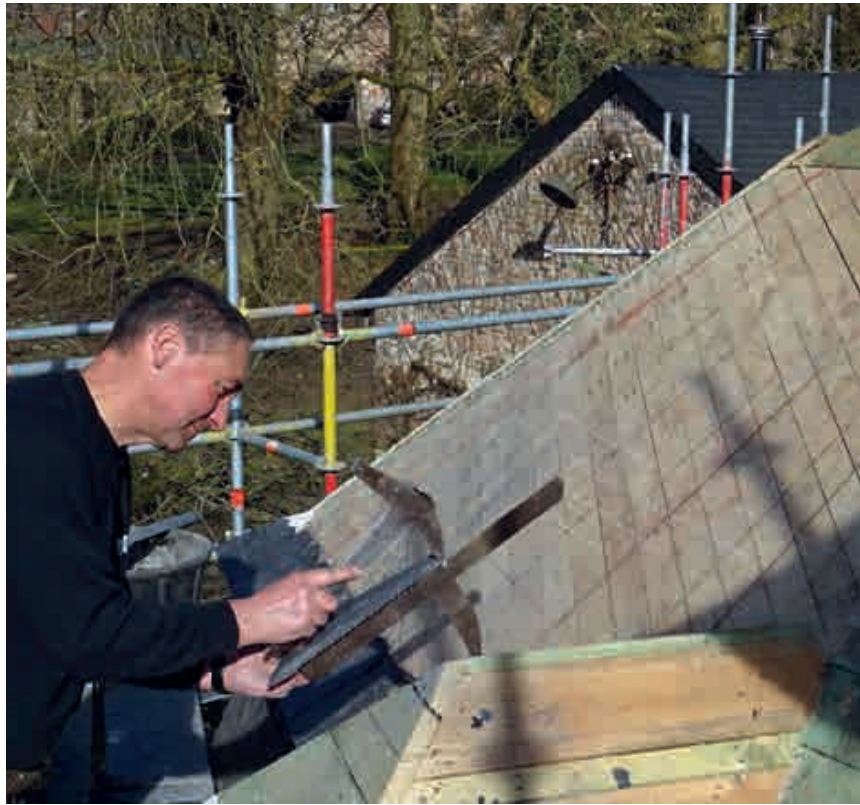
Fig. 36.- Façonnage des ardoises destinées à la surface voilée. © Gérard Bavay.
