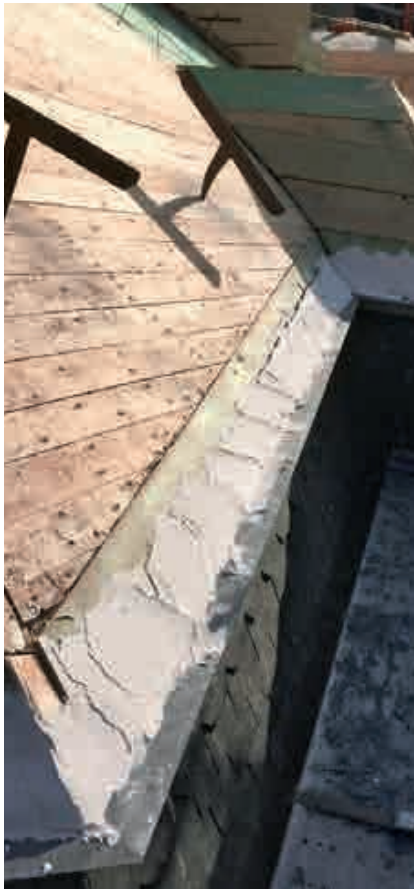
Fig. 22.- Préparation de la pose de la première ardoise en bas de versant. © Thierry Le Bihan.
