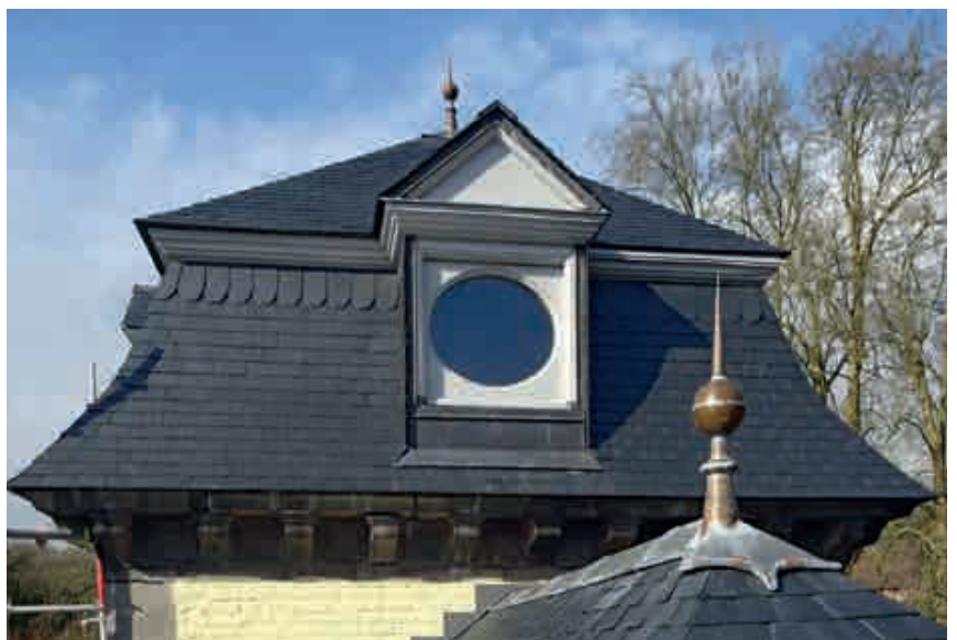
Fig. 14.- Volume central après restauration. Brisés avec coyau pour la partie basse de la toiture. Membron (ici renouvelé) séparant partie basse et partie haute. Terrasson avec croupe pour la partie haute. Lucarne à fronton restituée sur le modèle des deux lucarnes anciennes conservées. Épis de faitage restitués. Faîte en plomb. © Gérard Bavay.
