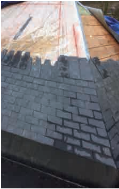
Fig. 30-31.- Aile sud. Couverture gironnée avec tracé préalable sur un voligeage en peuplier posé en oblique. La surface du voligeage est courbe. © Thierry Le Bihan.
