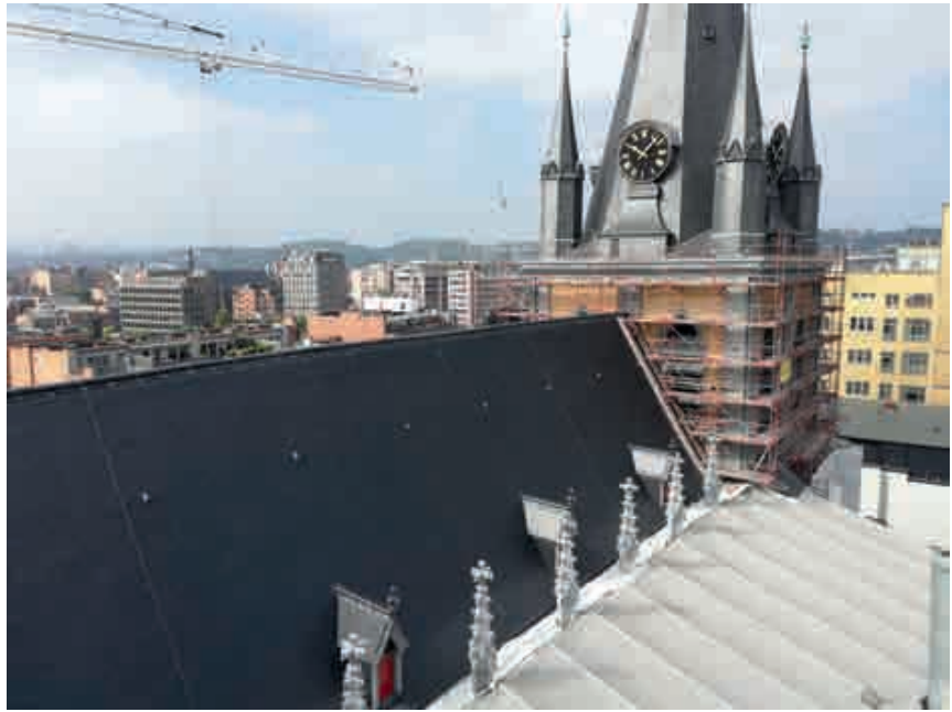
Fig. 13.- Toiture du vaisseau principal : le calage ponctuel de chevrons a permis de retrouver la planéité souhaitée. © Architectes associés s.a., société civile d'architectes.
