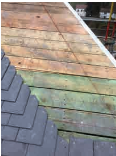
Fig. 21.- Dessin préparatoire et « remplissage » sur le nouveau voligeage. © Thierry Le Bihan.
