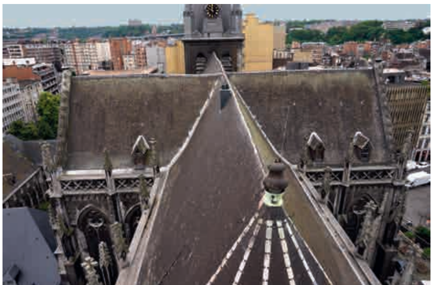
Fig. 4.- Toitures, avant restauration. © Architectes associés s.a., société civile d'architectes.
