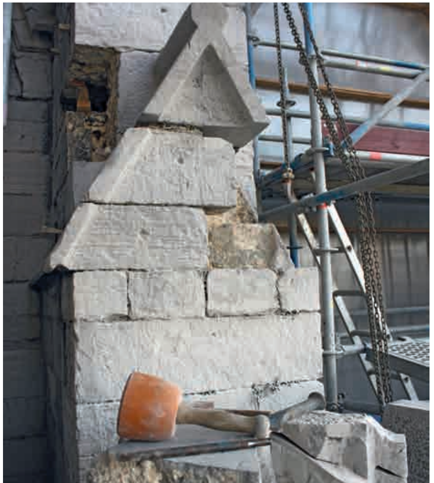
Fig. 27.- Restauration des pierres effectuées au maillet et ciseau. © Architectes associés s.a., société civile d'architectes.
