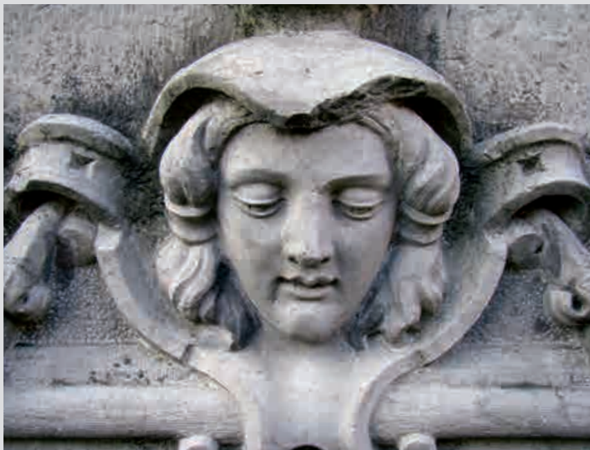
Fig. 1.- Détail d'un linteau montrant la variété des tailles, fine ciselure pour les modénatures, piqueté régulier à la broche pour les fonds, alors que les parties sculptées sont lissées (sans doute avec un abrasif fin) et que les cheveux présentent quelques traces de gradine. © Francis Tourneur, 2019.
