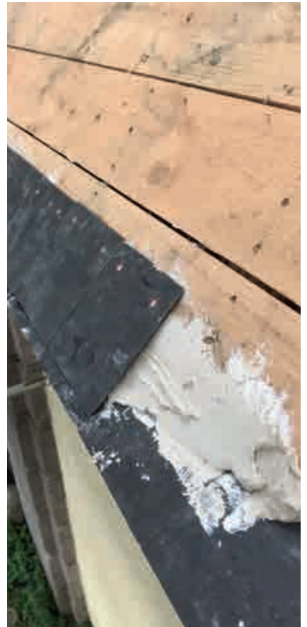
Fig. 23.- Pose de la première ardoise en bas du versant, avec confortation au plâtre. © Thierry Le Bihan.
