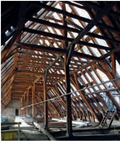
Fig. 9.- Les charpentes après le démontage des voliges. © Architectes associés s.a., société civile d'architectes.
