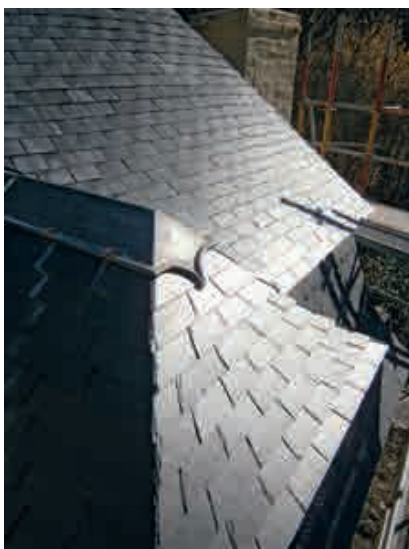
Fig. 34.- Finalisation de la couverture d'une lucarne, sous le soleil. © Gérard Bavay.
