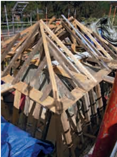
Fig. 17.- Volume central. Charpente et chevronnage en cours de restauration. L'ensemble paraît reposer sur une sablière, elle-même posée sur la lourde corniche en pierre bleue. En fait, à l'intérieur, ce sont deux entrants soutenant deux faux-entrants, soutenant eux-mêmes des poinçons en même temps que le membron, qui portent les chevrons et la couverture. Sous le membron, les chevrons sont introduits a posteriori entre la sablière et le membron. © Gérard Bavay.
