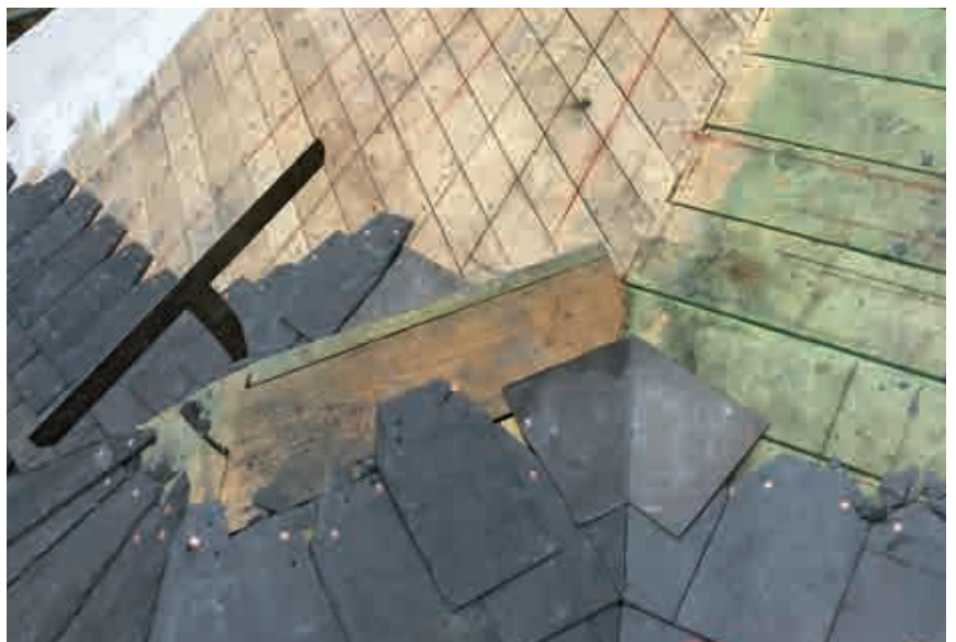
Fig. 32.- Détail de la pose d'un noquet de plomb dans la noue entre couverture de l'aile nord et couverture de la lucarne. © Thierry Le Bihan.
