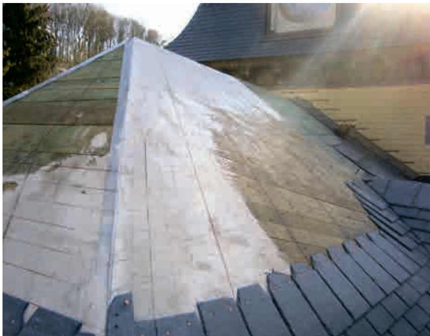
Fig. 35.- Voligeage voilé en peuplier avec régularisation au plâtre et tracés pour la découpe et la pose des ardoises © Gérard Bavay.
