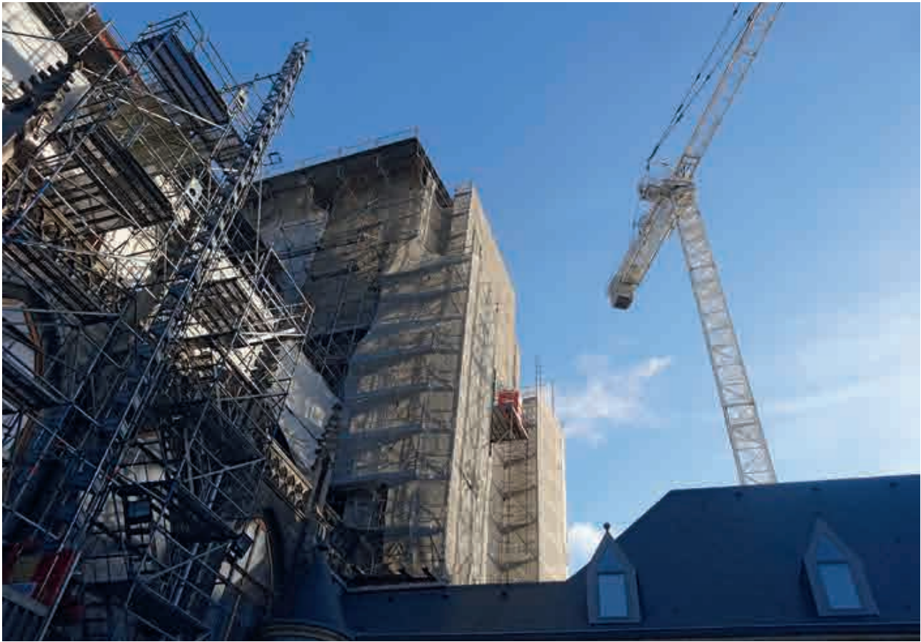
Fig. 7.- Installation de chantier en septembre 2016. © Architectes associés s.a., société civile d'architectes.
