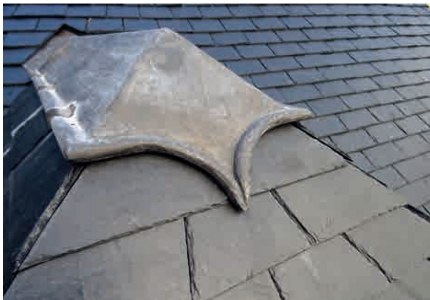
Fig. 25.- Finalisation en plomb du faîtage d'une lucarne.
