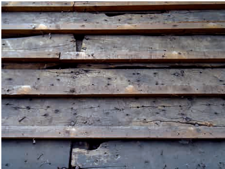
Fig. 12.- Traces de clouages successifs sur un voligeage ancien et peut-être d'origine. Les clous fixant les voliges sur les chevrons pourraient être d'origine. © Gérard Bavay.
