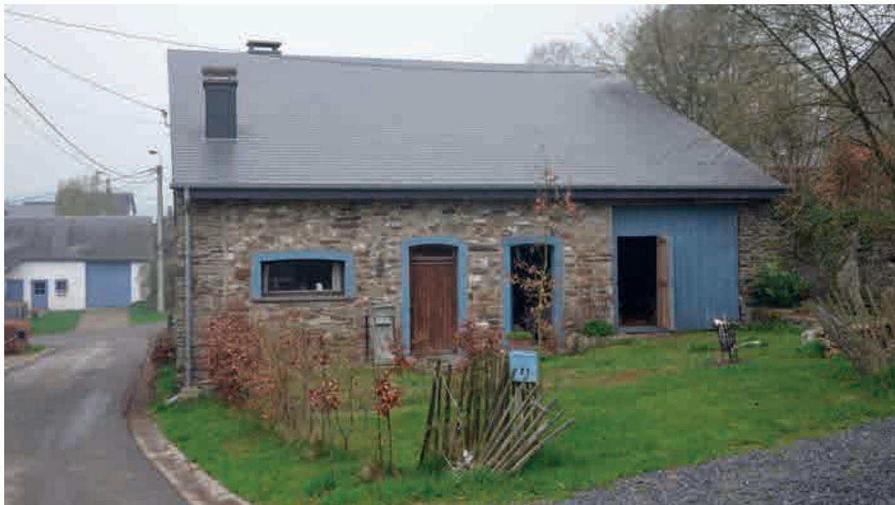
Fig. 1.- Ferme de Hierlot : mur gouttereau oriental. © Patrick Hoffsummer (ULg-CEA 2013).
