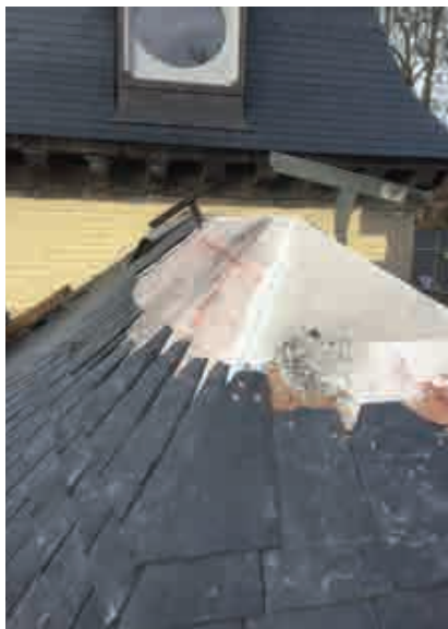
Fig. 37.- Façonnage et alignement des ardoises sur la surface voilée. © Gérard Bavay.
