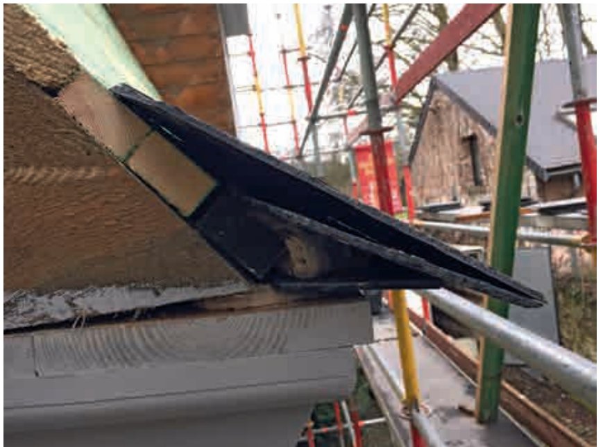
Fig. 24.- Détail de la pose des premières ardoises en bas de versant. © Thierry Le Bihan.
