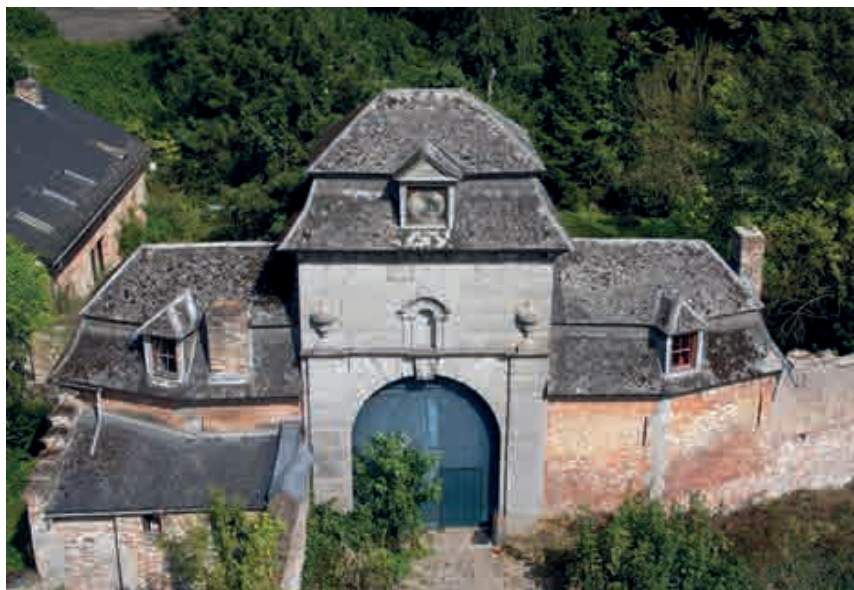
Fig. 4.- Porterie (avant restauration). Vue aérienne permettant de détailler les diverses facettes de la toiture et d'une partie de la volumétrie (vision à partir de l'extérieur de l'abbaye).
