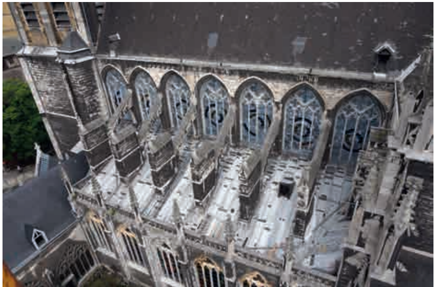
Fig. 3.- Élévation sud, avant restauration. © Architectes associés s.a., société civile d'architectes.
