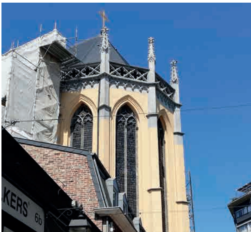
Fig. 22.- Peinture silicate appliquée sur la maçonnerie du chevet. © Architectes associés s.a., société civile d'architectes.
