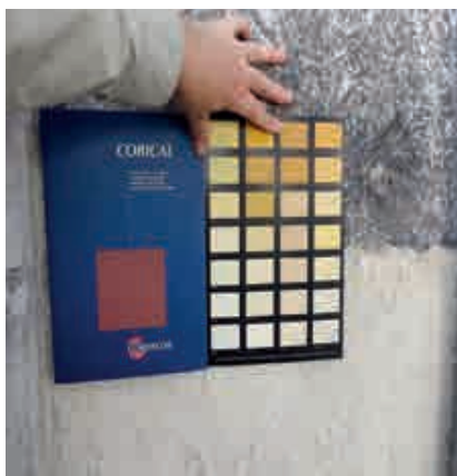
Fig. 20-21.- Recherches des teintes appropriées pour couvrir les maçonneries en calcaire du Bajocien. © Architectes associés s.a., société civile d'architectes.
