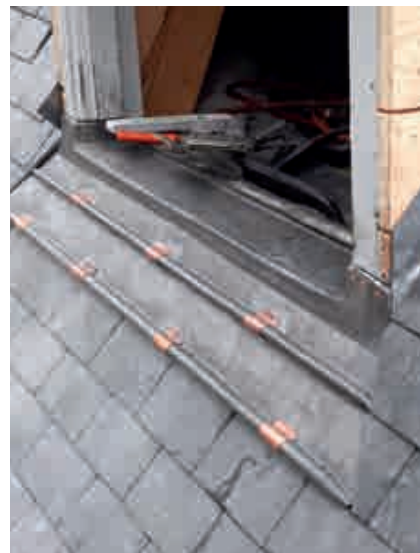
Fig. 41.- Traitement au plomb d'un appui de lucarne. État final.
