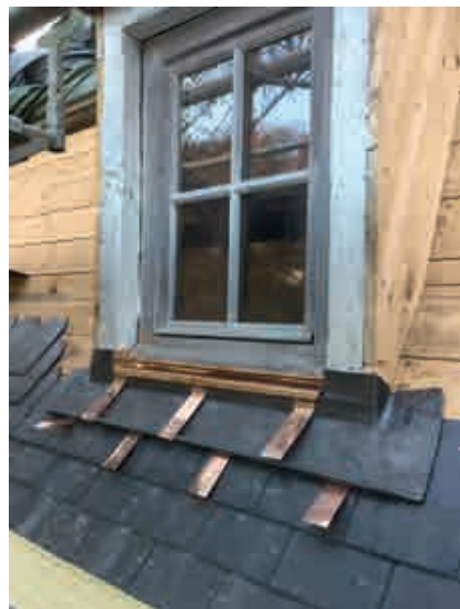
Fig. 40.- Traitement en plomb d'un appui de lucarne. Le cuivre joue un rôle de glissière pour contrecarrer les effets de la dilatation des feuilles de plomb.
