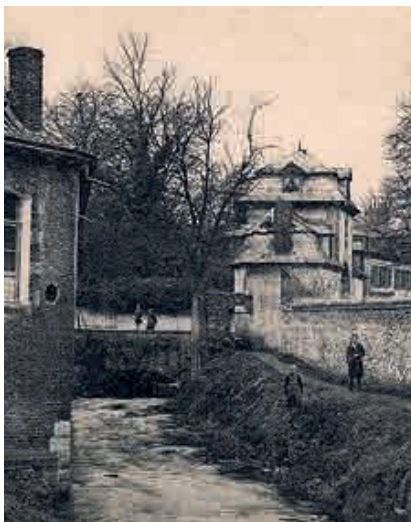
Fig. 3.- La ferme de la Basse-Cour (à gauche) avait été reconstruite en 1780 à l'extérieur du clos monastique. L'Obrechueil longe l'ancien portail et le mur d'enceinte.
