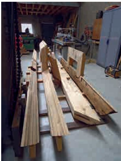
Fig. 18.- Les éléments conservés, restaurés ou restitués du membron à la sortie de l'atelier. Avec les extensions de membrons au niveau des lucarnes. © Gérard Bavay.
