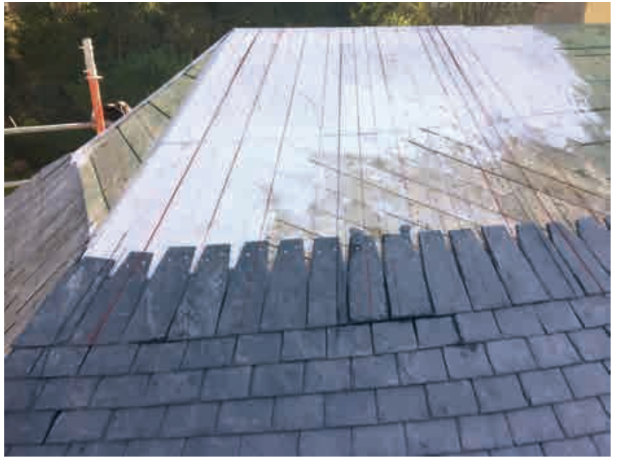
Fig. 30-31.- Aile sud. Couverture gironnée avec tracé préalable sur un voligeage en peuplier posé en oblique. La surface du voligeage est courbe. © Thierry Le Bihan.
