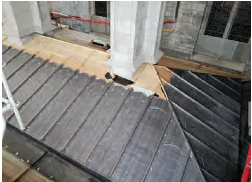
Fig. 14.- Toiture nord du collatéral du chœur. © Architectes associés s.a., société civile d'architectes.
