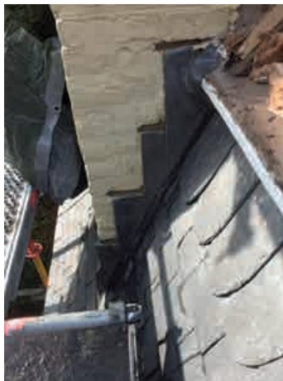
Fig. 39.- Traitement en plomb d'un solin entre la couverture du brisis d'une aile basse et la tour centrale.
