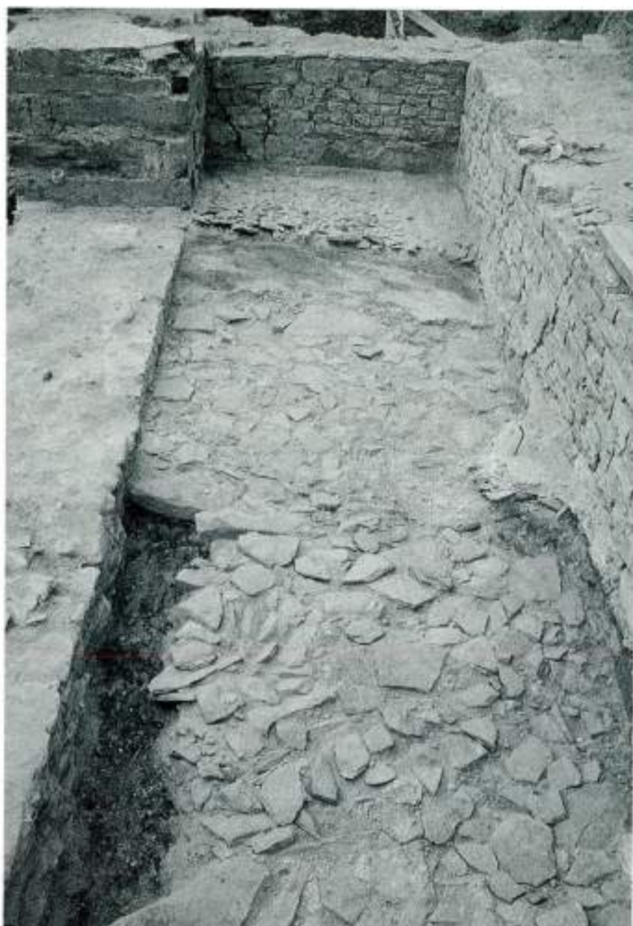
Fig. 6. Radiers successifs de fondation des pavements en mortier des églises médiévales (photo P.M. Vêche, 1900).
