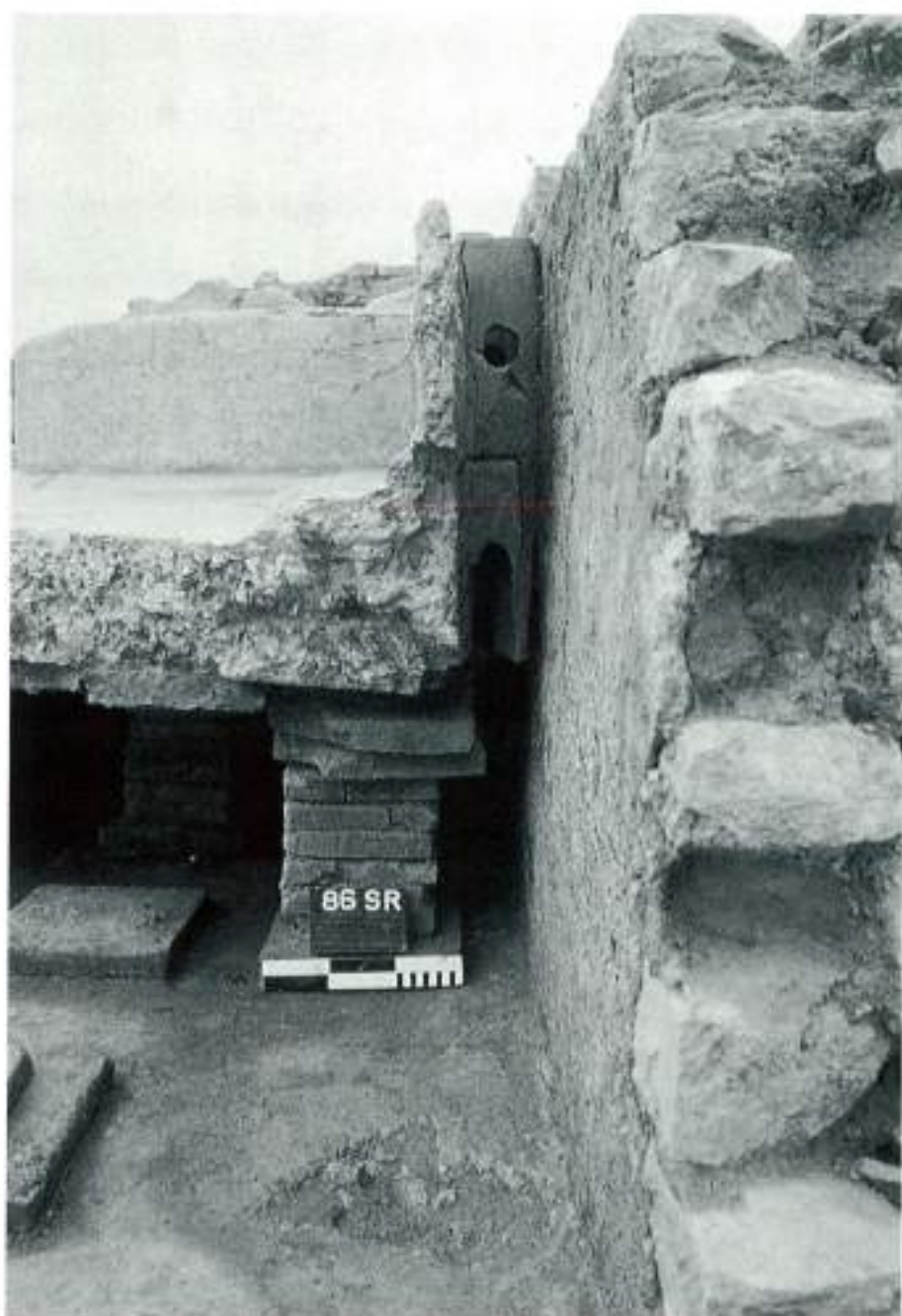
Fig. 7. Détail du système sur hypocauste du solium du bain chaud.
